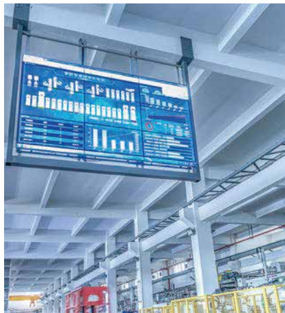
中央控制系统 Central Control System
